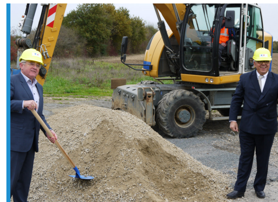
Lancement des travaux d'aménagement de la déviation de Bouvron, en présence de Monsieur Mohamed SAADALLAH, sous préfet de l'arrondissement de Châteaubriant-Ancenis et de Monsieur le maire de Bouvron.
